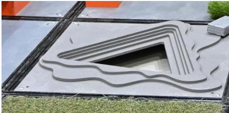
Конструкция состоит из нескольких слоев фанеры, уложенных параллельно друг на друга, которые формируют углубление треугольной формы.
